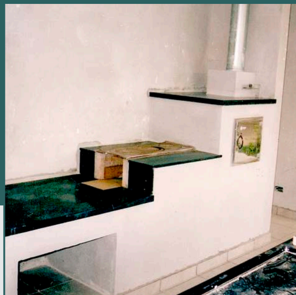
conjunto FOGÃO E FORNO reboco
