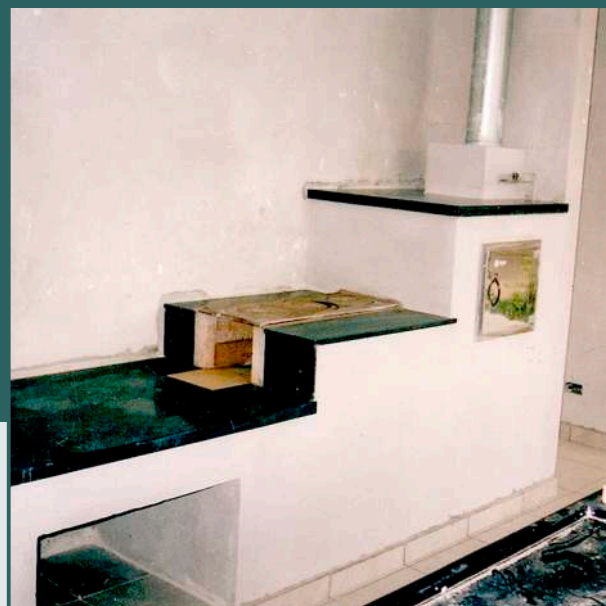
conjunto FOGÃO E FORNO reboco
